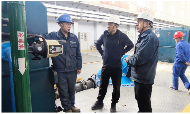
顾靖超（左二）指导开展空—水冷电机冷却系统设备改造。
