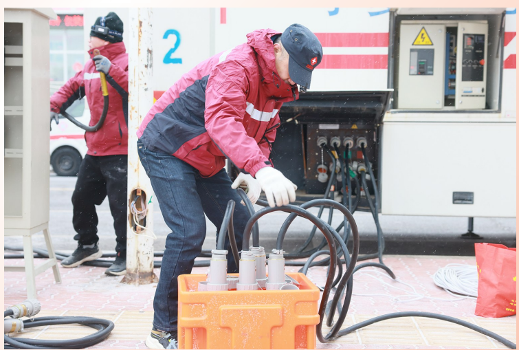
巡回医疗队医护人员在调试手术车、检验车等线路。
