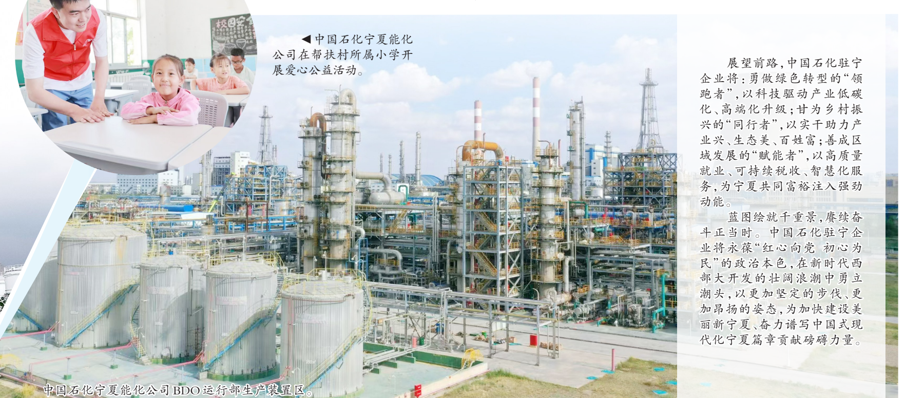
中国石化宁夏能化公司BDO运行部生产装置区。
