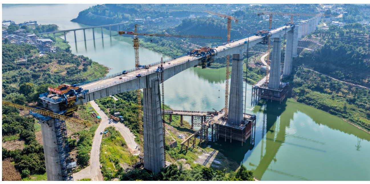
这是8月18日拍摄的渝万高铁梁溪河双线特大桥施工现场(无人机照片)。
