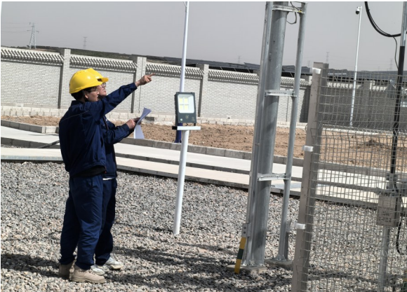
工作人员在宁夏华电隆基绿电园区日常工作检查。
