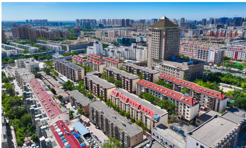
日前,经过改造的兴庆区荣丰苑小区焕然一新。
