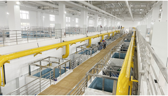
▲银川都市圈城乡东线供水工程。
