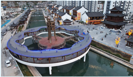
这是4月22日拍摄的武都万象街景观(无人机照片)。
