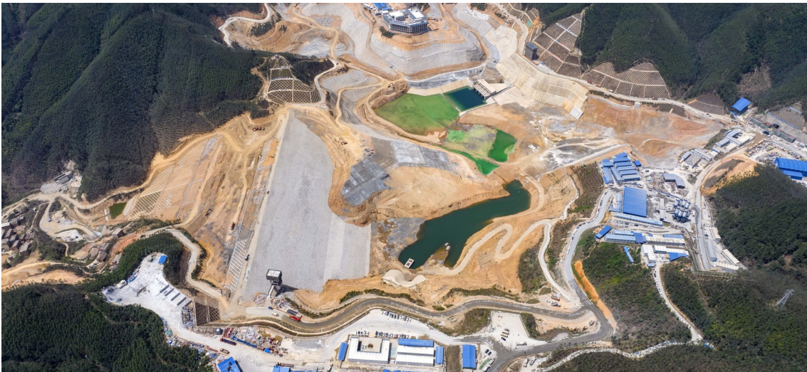
4月15日，建设者在南宁抽水蓄能电站下水库工程现场进行土建作业(无人机照片)。
