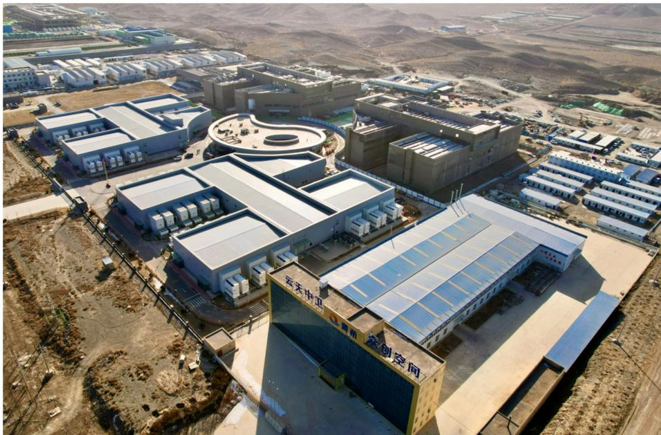
近日,俯瞰中国电信中卫算力枢纽数据中心。中国电信宁夏数据中心是中国电信集团公司西部数据运营中心、天翼云计算中心、智算中心、互联网骨干网络节点。项目占地121亩,计划总投资20亿元,建设6栋独立机房、1栋运维楼,总建筑面积4.165万平方米,规划建设标准机架2.5万个,服务器装机能力15万台以上,采用全自然风冷。项目分二期建设,一期2栋数据机房和1栋运维楼已建成,建筑面积2.6万平方米,已安装标准机架6800个;二期2栋数据机房已建成,正在安装机电设备,计划2025年4月投入运营。
