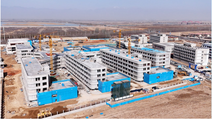
3月12日,空中俯瞰银川市阅海湾高级中学工程项目建设现场。银川市阅海湾高级中学工程项目建设基础建设已具雏形,计划于今年6月底竣工。今年,银川市将进一步深入推进基础教育扩优提质行动,科学配置教育资源,强化施工精细化管理,努力办好人民满意的教育,持续擦亮“教育在银川”品牌。本报记者 陈治学 摄
