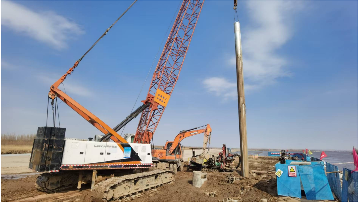
2月24日,在黄河宁夏段河道治理工程(平罗县治理区)施工现场,工人们紧张有序地对施工河道进行铅丝笼编织袋进占和灌注桩制钢管加工。黄河宁夏段河道治理工程是保障黄河“安澜、健康、美丽”的战略性工程,其中黄河平罗段总投资3.47亿元,工程完工后,黄河平罗县段河势将得到有效控制,防洪标准进一步得到提升,河段堤防实现闭合,有力保障沿河群众生命财产安全。
