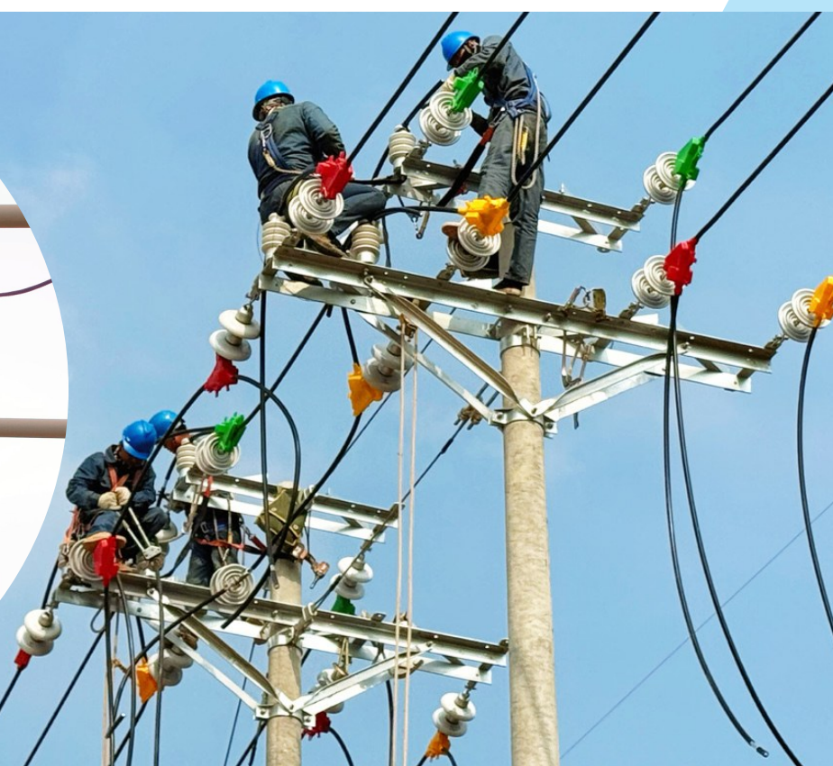
电力工人在建设重点项目配套电力设施。
