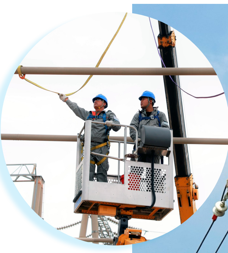
电力工人进行高空电力抢修。
