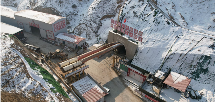
这是正在施工的兰合铁路考勒隧道2号斜井(12月17日摄，无人机照片)。日前，由中铁二十局承建的兰合铁路考勒隧道掘进突破11000米，进入攻坚冲刺阶段。考勒隧道位于甘肃省临夏回族自治州东乡族自治县境内，全长14659米，隧道内土质结构主要为湿陷性黄土，地质构造复杂，是兰合铁路全线重难点控制性工程。
