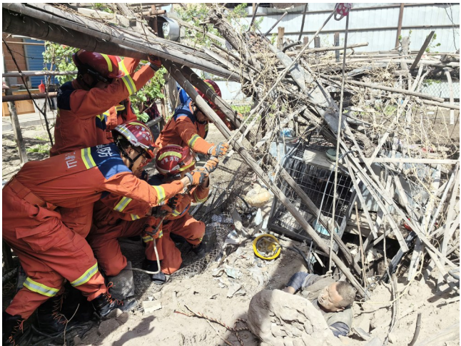
4月29日,石嘴山市消防救援支队青山特勤站消防救援人员解救因院墙倒塌腿部被埋压的被困人员。
