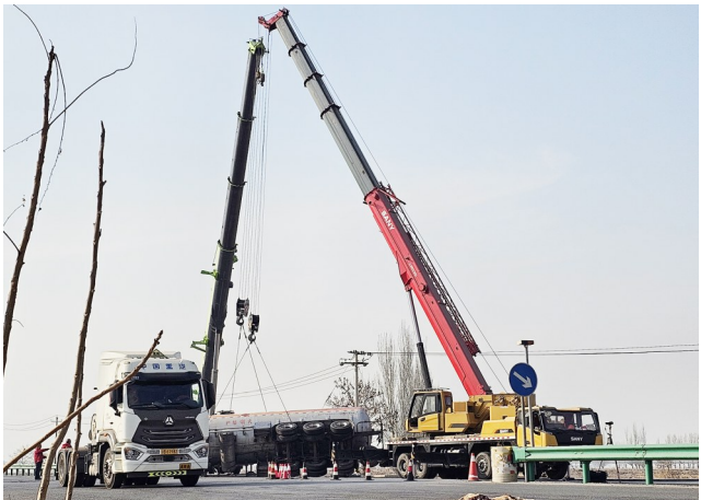
1月30日,惠农区燕子墩乡一辆液化石油气罐车与轿车相撞发生侧翻导致油箱泄漏,红果子消防救援站、定远街消防救援站消防救援人员经过4小时紧急处置,成功排除险情。
