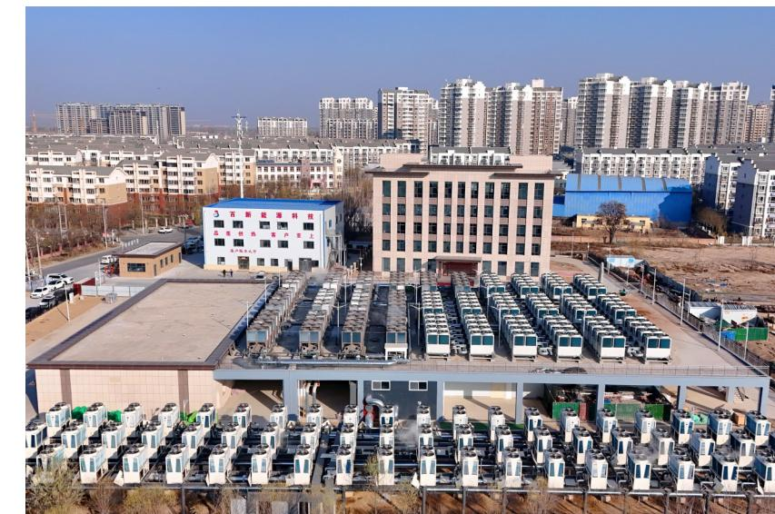
12月5日,在银川北部热源厂二期项目现场,一台台放置在二楼设备平台上的空气能热泵整齐排列。
