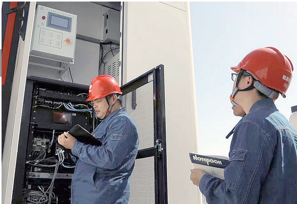
技术人员在储能电站记录储能变流器控制参数。
