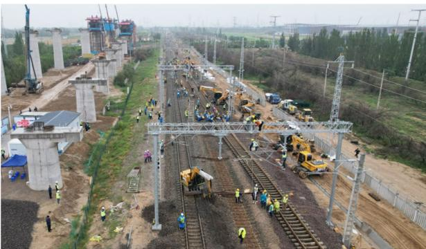
这是包银高铁银巴支线改建包兰线轨道拨接施工现场(无人拍照,9月10日摄)。
