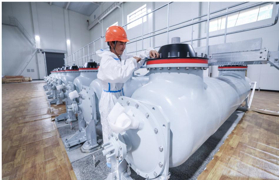
9月3日,在500千伏长兴变电站建设现场,国网浙江省电力有限公司的施工安装人员在500千伏GIS无车间进行设备安装。
