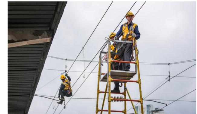
8月6日,工人在安顺站进行接触线更换施工。
