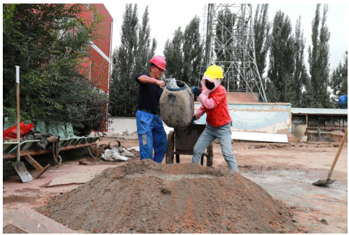
施工人员正在搅拌混凝土。
