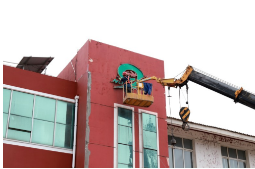
施工人员粉刷教学楼外墙。
