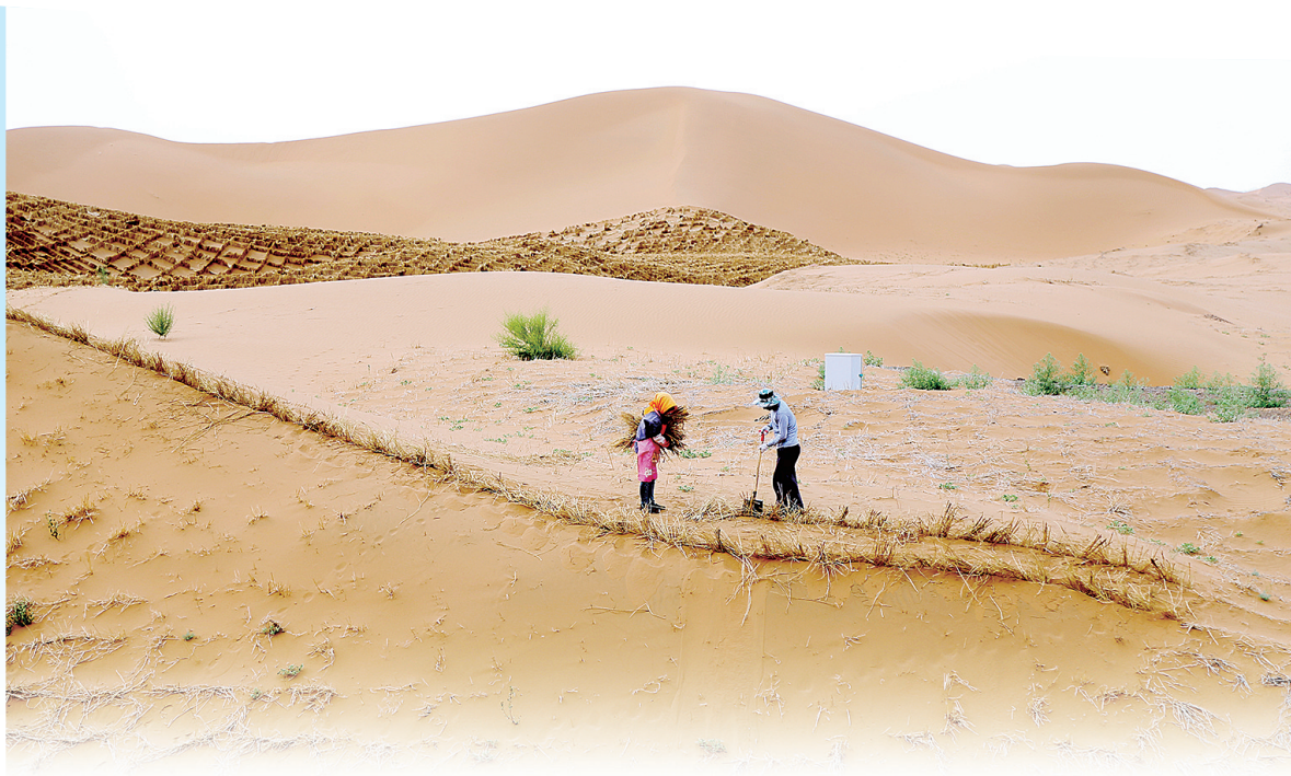
在中卫市腾格里沙漠边缘,工作人员扎制麦草方格。
