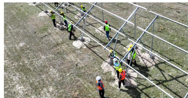
6月11日，中建二局施工人员在安装光伏支架(无人机照片)。
