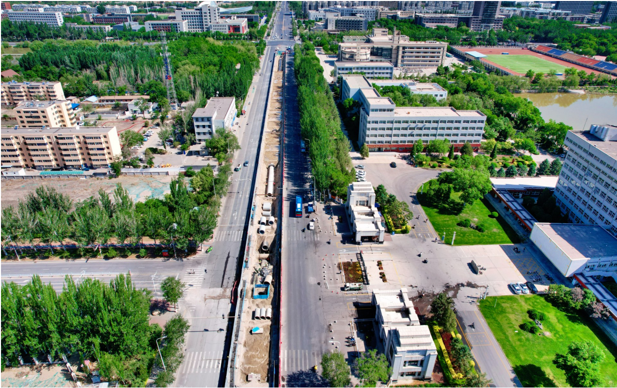
5月22日,记者航拍西夏区文萃北街(怀远路—贺兰山路)雨水管道工程,各标段施工点有序推进。该项目建成后,将进一步完善西夏区中部片区排水防涝设施,强化西夏区中部片区雨水径流源头减排、控制合流制溢流污染,加快推进银川市海绵城市建设。
