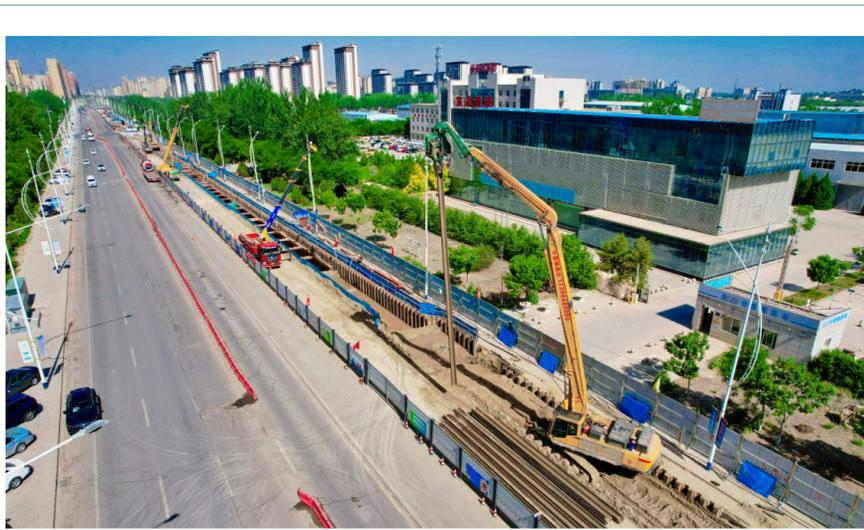
5月16日,兴庆区银川市第一再生水厂再生水利用管网(一期)工程正在如火如荼推进。据悉,银川市第一再生水厂再生水利用管网(一期)工程项目总投资4558.40万元,拟在贺兰山路、丽景街、正源街等路段分别配套新建DN400—DN500再生水管道,对银川市三区区内既有21处断点、堵点再生水管道进行修复。项目建成后,将为园林绿化及城市杂用提供优质的补充水源,管网覆盖绿化面积将从529.37公顷增至659.77公顷,每年可节约黄河水指标427.53万立方米,切实减少对黄河水的依赖,有效缓解区域水资源供需矛盾。
