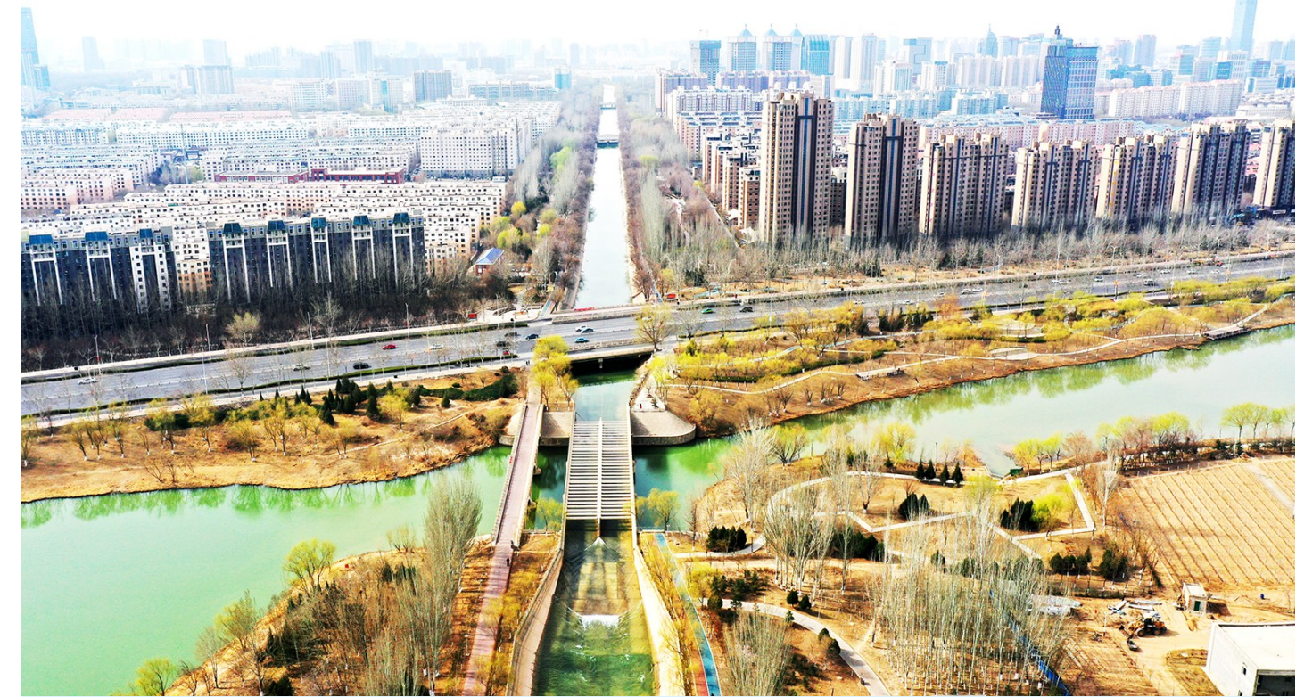
3月26日，记者航拍黄河水经银川唐徕渠横穿整个城市。据悉，宁夏2024年引黄灌区春灌工作主要为生态补水及春耕灌溉提供水源，补水将有效提升域内湖泊的水位和水质，为银川东南水系、西北水系、宝湖、典农河、沙湖、星海湖等湖泊生态湿地提供活力。 本报记者 陈治学 摄
