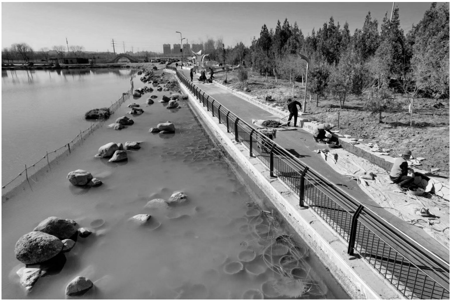
3月24日，银川市闽海湖边，工人正在加紧铺设路面。
