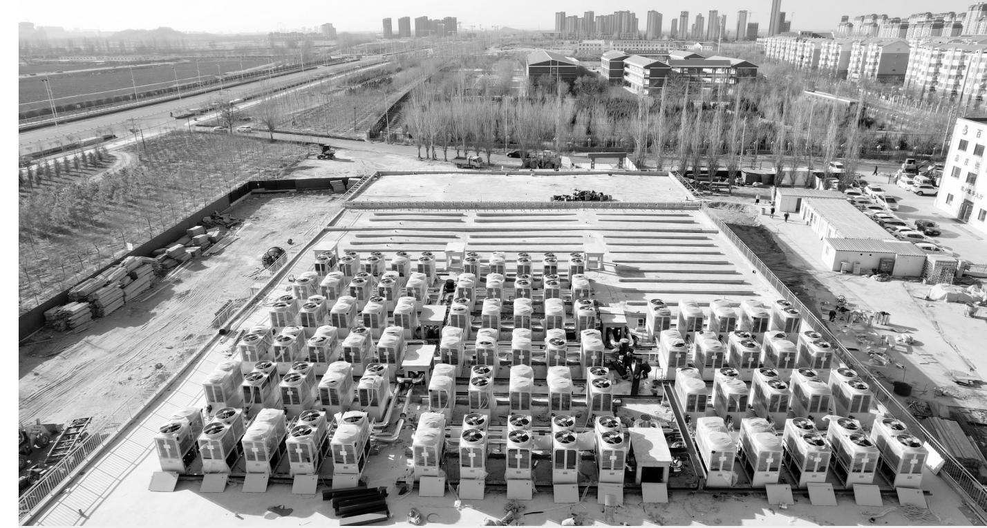
12月11日,宁夏百新能源科技发展有限公司北部热源厂清洁能源供热工程项目建设全力推进中,确保月底投产运行。项目建成后,将成为银川市农村地区第一座“光伏+空气源热泵”供热的大型集中热源项目,有效解决丰登片区供热能源结构单一的问题,进一步提高供热可靠性和能源利用率。 银川北部热源厂项目位于金凤区丰登镇丰润南巷东侧、哈尔滨路北侧,占地20亩,总投资1.93亿元,是银川市清洁取暖重点项目。该项目计划分两期实施,今年计划完成一期建设,新增供热面积40万平方米。 本报记者 陈治学 摄
