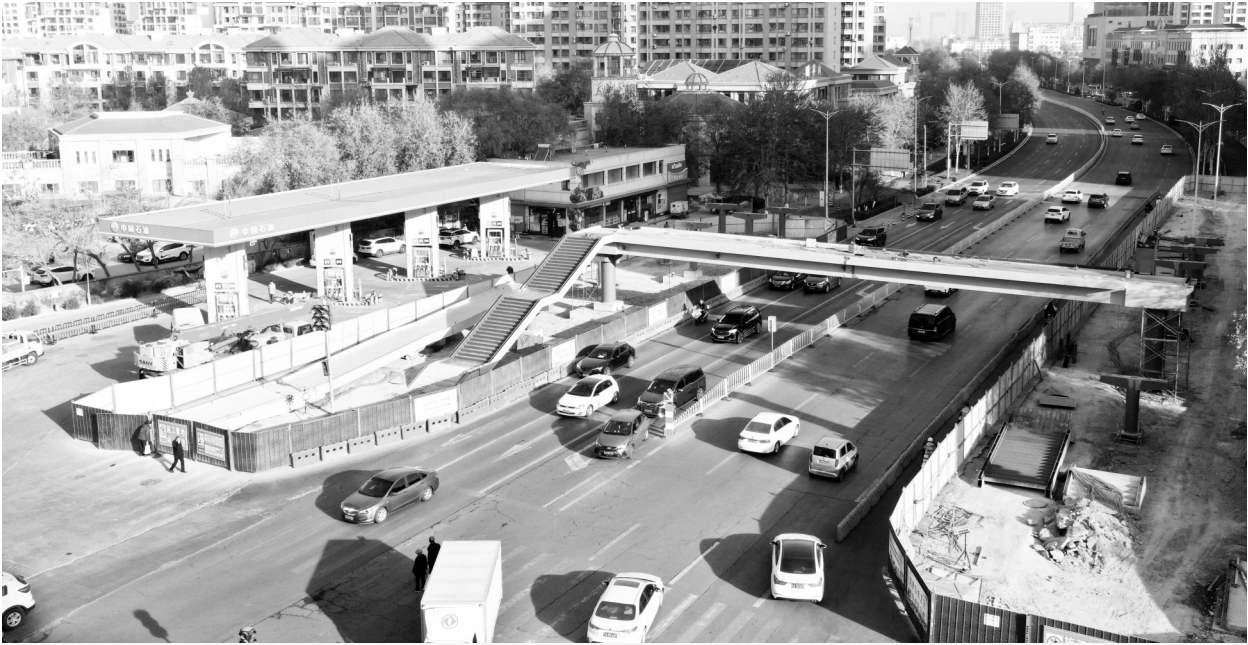
11月21日,俯视正在加紧施工中的正源街与宝湖路交叉口快速化改造工程北侧过街天桥。据了解,正源街与宝湖路交叉口快速化改造工程中,正源街与宝湖路交叉口南北两侧将各建设一座天桥,方便行人通行。作为银川市交通疏堵重点工程之一,该项工程预计明年1月31日前具备通车条件,届时正源街与宝湖路的交通承载能力将得到大幅提升。
