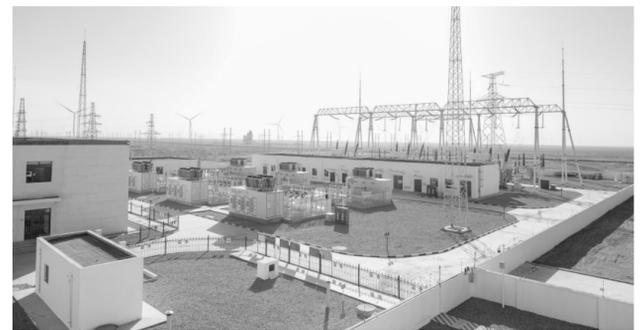
这是11月7日在甘肃省酒泉市瓜州县秦源桥南第三风电场拍摄的升压站。11月7日，位于甘肃省酒泉市瓜州县的发电侧50MVar分布式调相机示范项目开工建设。调相机被誉为电网的“稳压器”，可有效解决新能源大规模接入电网带来的电压稳定问题，提升输电安全可靠，助力新能源电力消纳。
