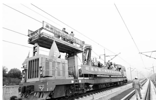
10月10日,中国中铁电气化局施工人员在杭温铁路上进行接触网导线架设作业。
