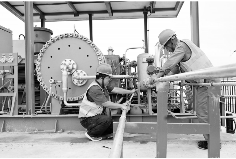
8月10日，工人在中国能建张掖氢能综合应用示范项目调试氢气加压装置。 甘肃省张掖市地处河西走廊，太阳能、风能、水能、生物质能等资源富集。近年来，张掖市充分利用地域优势，大力发展新能源、氢能源和清洁能源装备制造，打造清洁能源产业集群，助力当地经济绿色发展。截至2023年6月底，张掖市风光发电项目已建成装机321.05万千瓦，在建308.85万千瓦。 新华社发
