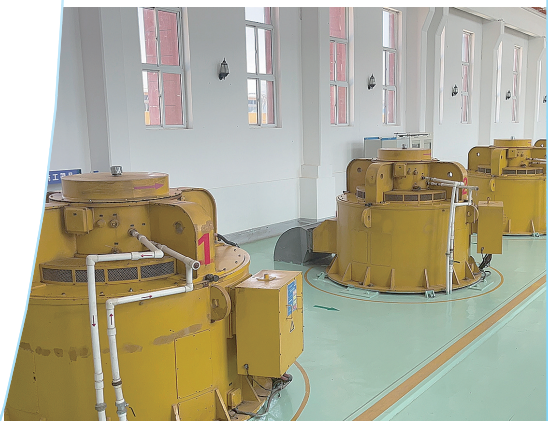
▲固海扬水工程泉眼山泵站内的电机,为该扬水工程提供电能保障。
