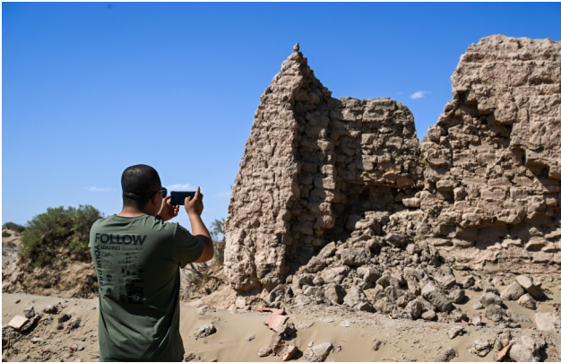
近日,额济纳旗文物保护中心工作人员拍摄红庙遗址坍塌情况。
