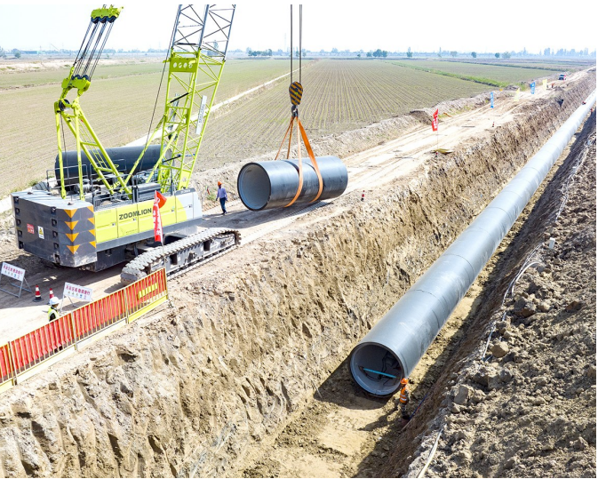
5月30日，银川都市圈城乡西线供水水源工程石嘴山支线工程前进农场段、平罗崇岗段、贺兰暖泉段施工现场一片繁忙景象。 据悉，银川都市圈城乡西线供水水源工程石嘴山支线工程建设输水道长68.8公里，340万立方米调蓄水库1座。自今年3月以来，各工段加紧施工，按照建设单位进度计划，年内管道工程全部完成；调蓄水库预计6月开工，年内完成80%，明年6月全部建成投入使用。 本报记者 陈治学 摄
