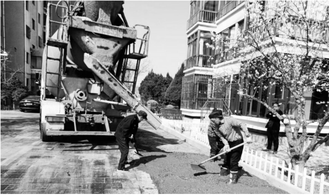
小区内道路施工火热进行。本报记者 张玉香 摄
