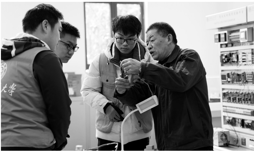
3月18日,在上海交通大学闵行校区的智能电网大楼,电工师傅潘国才指导学生组装智能配电箱。
