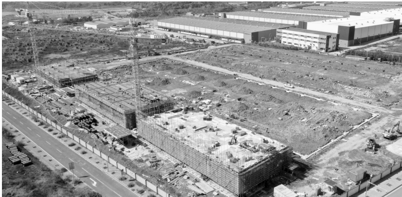
这是 3 月 13 日拍摄的重庆东港汽车电子产业园项目建设施工现场。日前,由中铁二十局承建的重庆东港汽车电子产业园项目在加速推进。项目建成后,将助力重庆形成更为完整的新能源汽车产业链条和汽车产业转型升级。 新华社发
