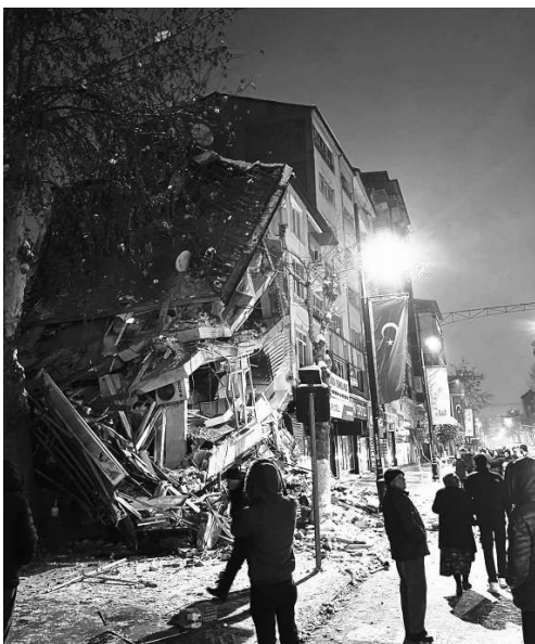
土耳其马拉蒂亚一处倒塌的建筑。
