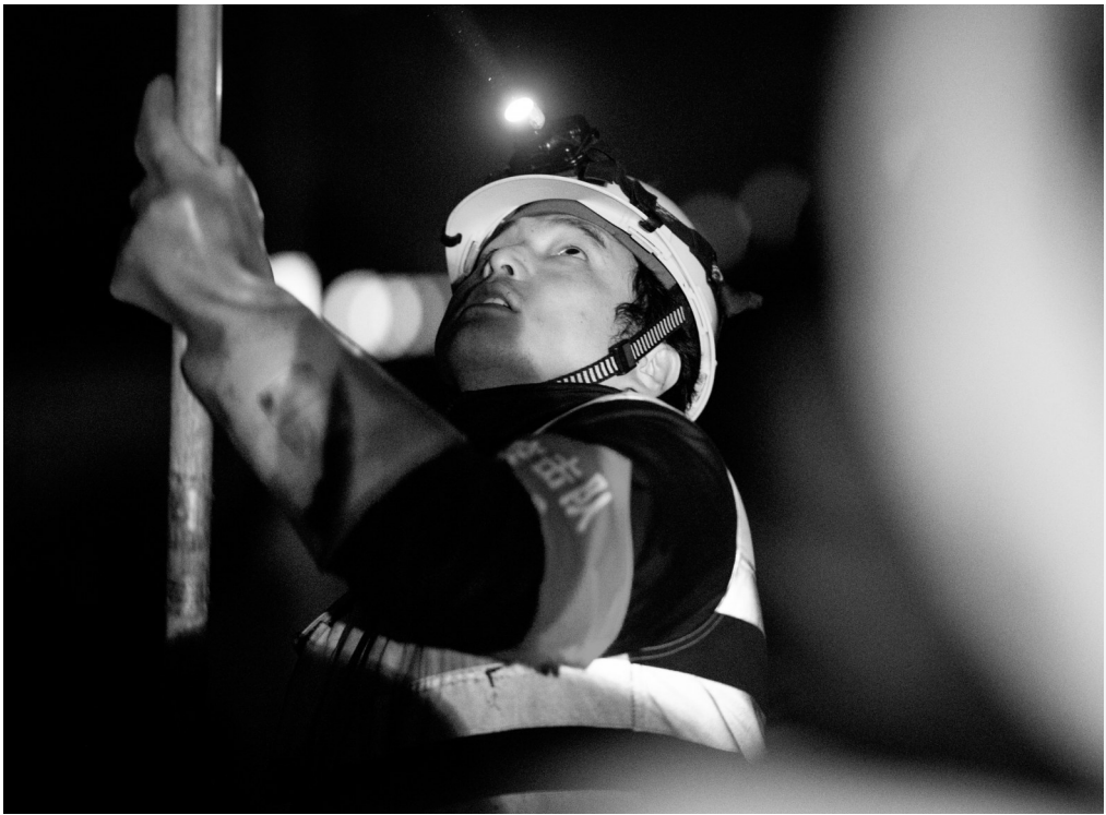
2月1日,接触网检修工人在悬挂地线。 铁路接触网供电设备是否正常运转,关系着每趟列车的安全运行。春运期间,中国铁路武汉局集团有限公司武汉供电段高铁接触网检修工人利用0点到6点的“天窗点”,头戴安全帽、身穿反光服,对京广高铁武汉段的接触网进行检修、维护,为高铁供电保驾护航。 新华社发
