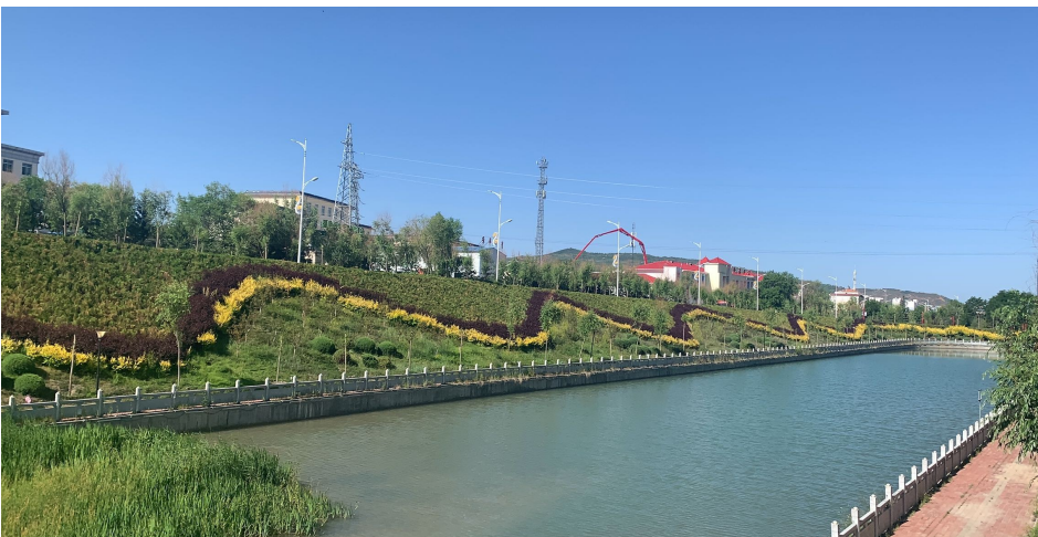
固原市隆德县渝河流域综合治理段。
