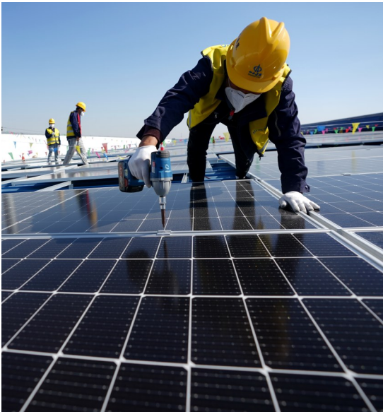
日前，工人在河北省唐山市芦台经济开发区一家企业厂房屋顶安装光伏发电板。 近年来，河北省充分发挥新能源产业开发的带动作用 and 上游装备制造业的支撑作用，推动新能源发电和上游装备产业协调发展，着力构建新型电力系统，实现全省新能源增长、消纳和储能协调发展，为全省能源产业低碳转型和经济高质量发展贡献力量。2022年，河北省力争新能源发电新增装机800万千瓦以上，完成投资1000亿元左右。 新华社发
