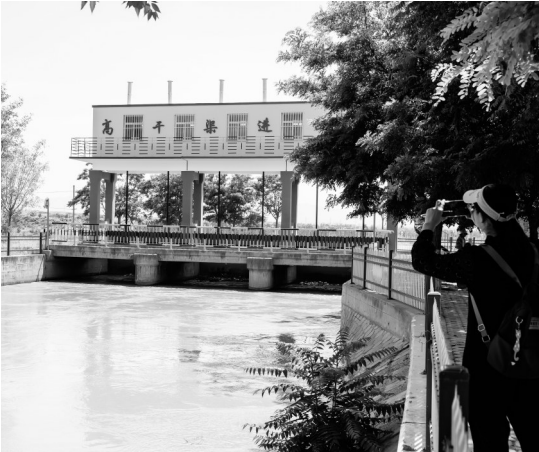
中宁县高干渠、七星渠等水渠承担着自流灌区32.4万亩农田灌溉和中部干旱带三大扬水供水任务。
