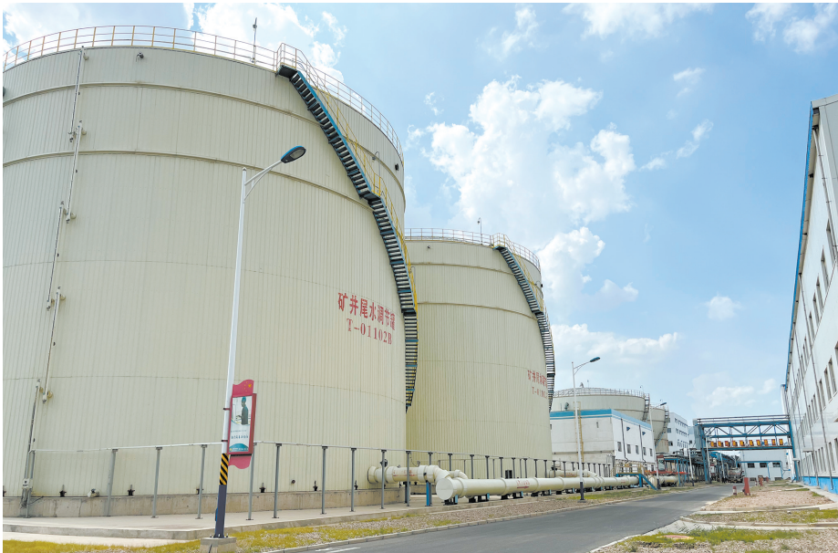
国家能源集团宁夏煤业水务公司(水务管理中心)内的矿井尾水调节罐。
