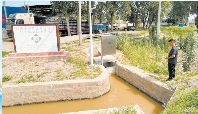
平罗县姚伏镇高荣村提闸放水由手动变自动,让水不再“乱跑”。
