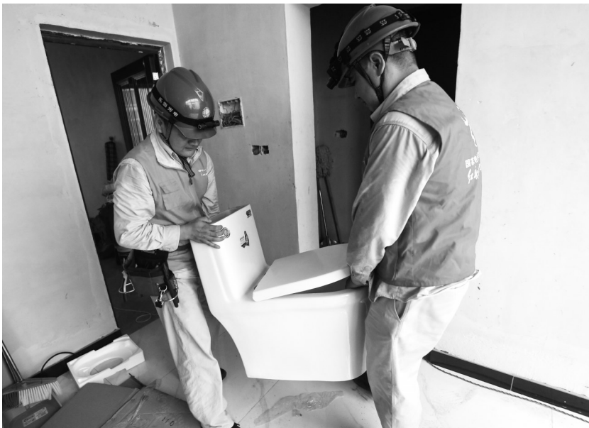
7月26日,工作人员在东阳市虎鹿镇龙山村低保残疾人杜有女的老房子里搬运新的抽水马桶,进行旧屋装修改造。 浙江省东阳市“幸福蜗居”项目从2016年开始启动,致力于帮助农村低保残疾人家庭改善居住环境。目前,该项目已累计帮助东阳市202户低保、残疾家庭实现安居梦。
