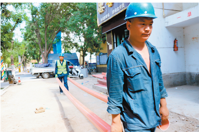
▼在海宝西区,建筑工人谭庆余在工作。
