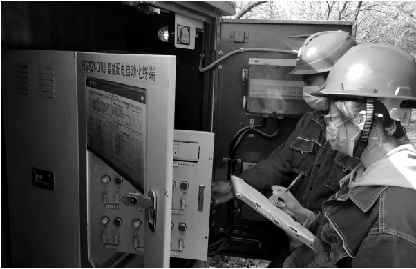
在原州区河川乡明川村的光伏项目基地，国网固原供电公司工作人员在检修电机。
