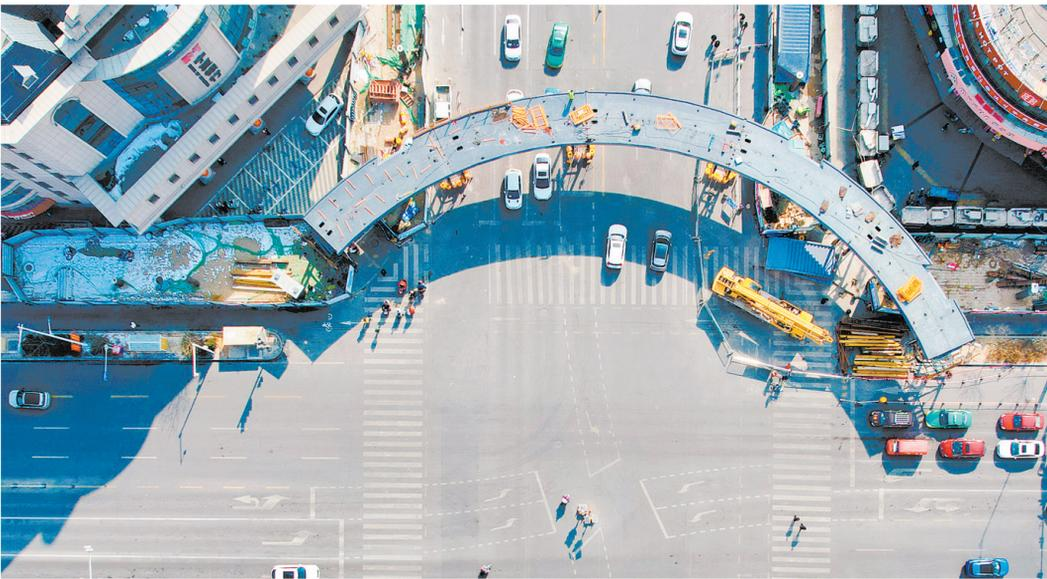
2月13日，俯拍正在加紧建设的银川市怀远路—萃萃街人行过街天桥，目前工程南侧桥面已经装架完成。据了解，这是银川市首条环形过街天桥，采用环形八跨设计，每个转角都有两条楼梯供行人使用，楼梯长度达到235.305米。该天桥的建设将有效提高人流密集区域行人的通行安全，也将成为银川城西新的地标建筑。 本报记者 陈治学 摄
