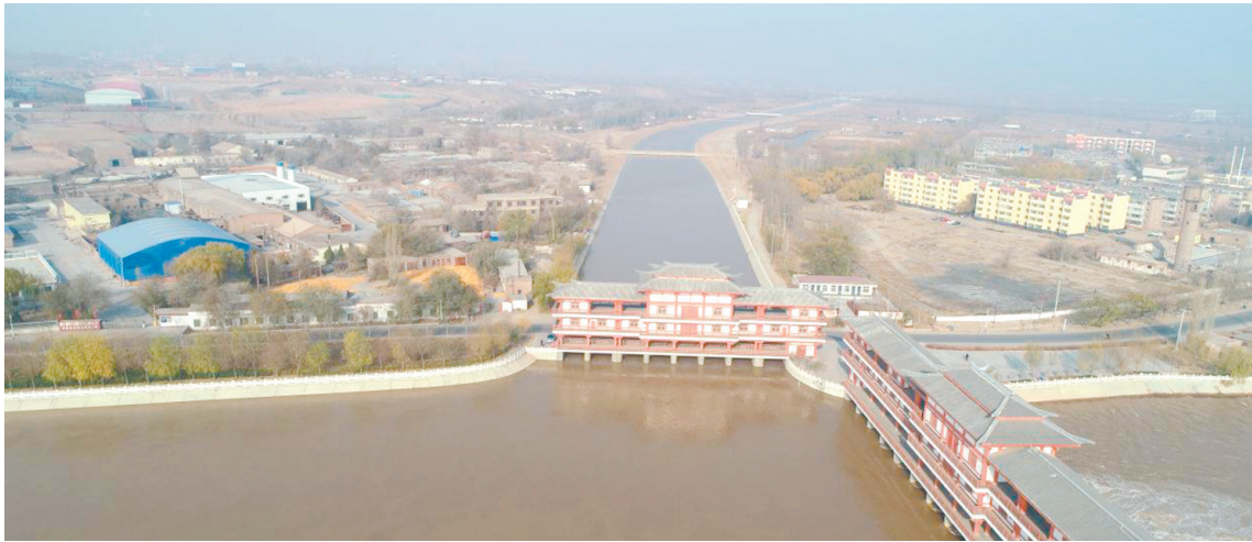
西干渠扩整改造完工。
