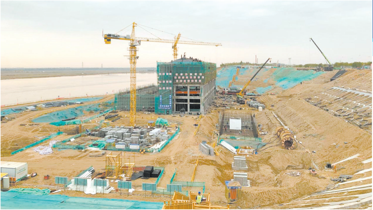
银川都市圈中线供水工程现场,一座水源泵站进行厂房封顶。
