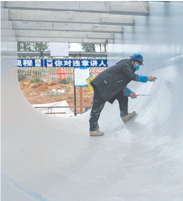
固海扬水灌区续建配套与现代化改造工程现场,一名工人对渡槽进行聚脲涂层。
