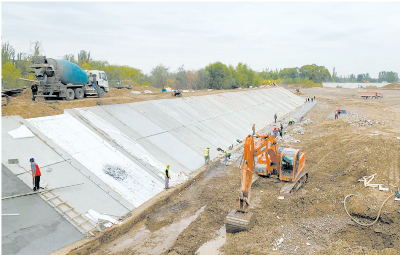
银川都市圈中线供水工程现场。
